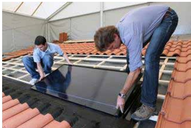
2 Insérer les modules du bas vers le haut et de droite à gauche.
