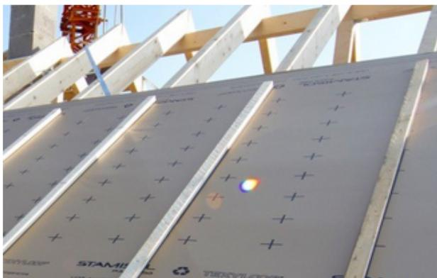
Figure 1: Sous-toiture étanche à la pluie (selon ZVDH)
